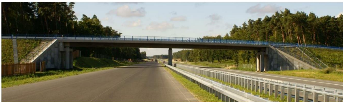
Widok obiektu nad drogą krajową nr 25 (zdjęcie przykładowe)
